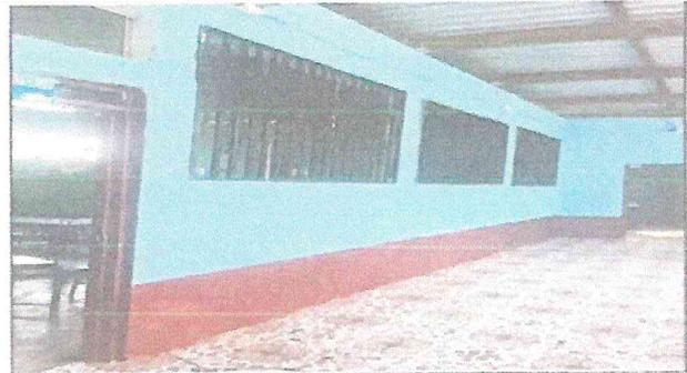
Foto8: Se muestra la finalizacion de cambio de ventanas de vidrio a la cual se les fueron colocados valcones de metal.
